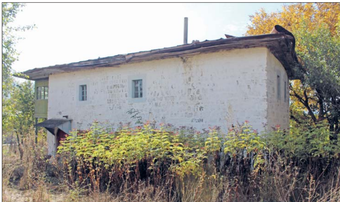
Современное состояние дома. Фото 2016 г.
