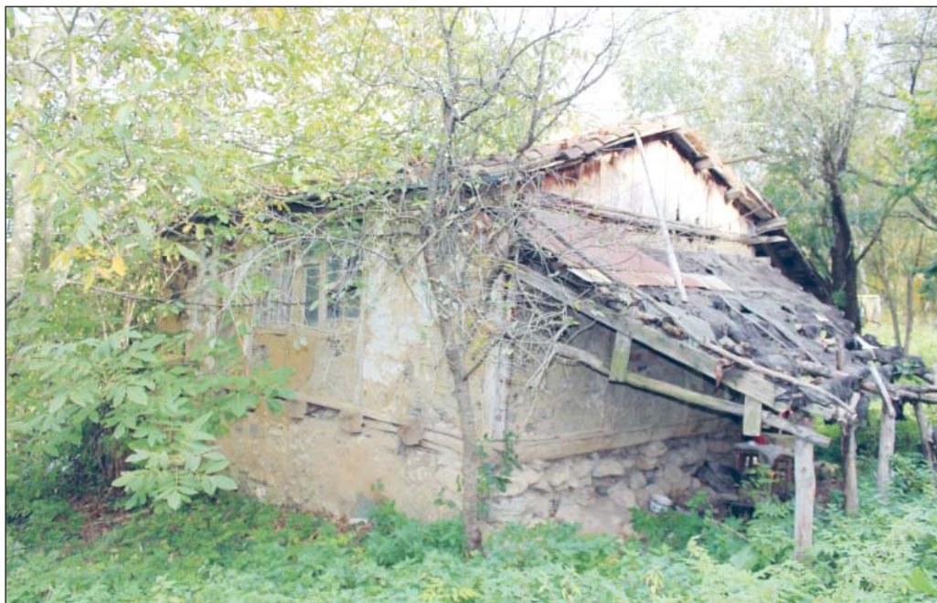
Вид дома с северо- востока. Фото 2016 г.
