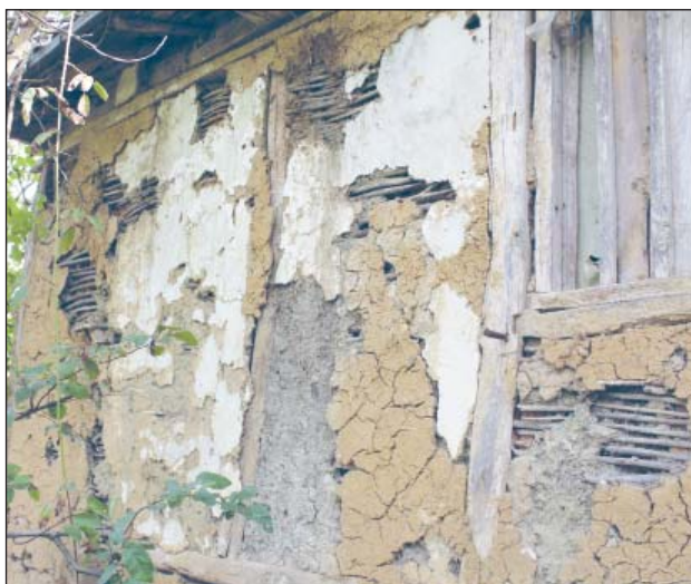
Фрагмент конструкции стены дома в с. Коклуз. Фото 2016 г.
