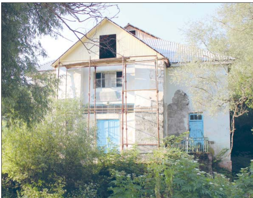
Современное состояние фасада мечети. Фото 2016 г.
