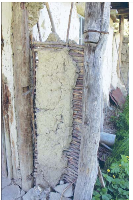
Фрагмент конструкции стены
