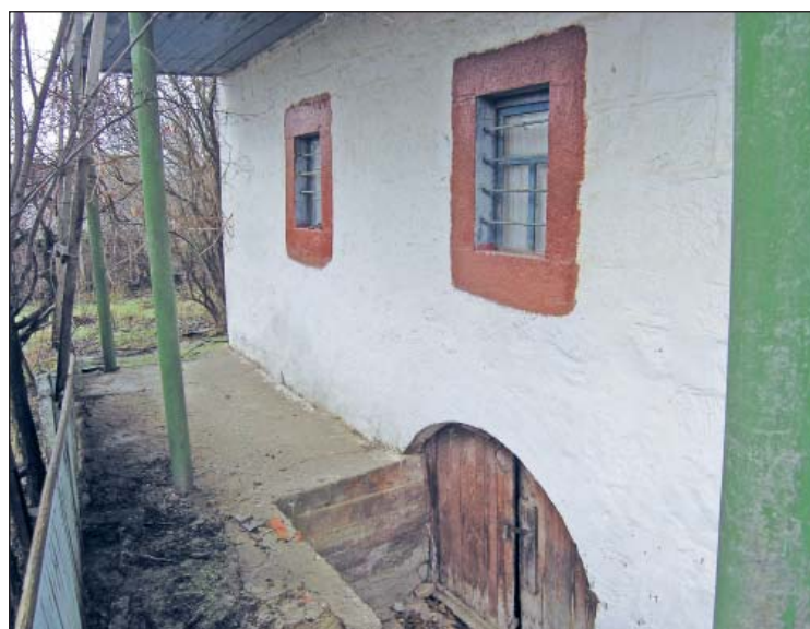
Южный фасад и дверь в подвал.
