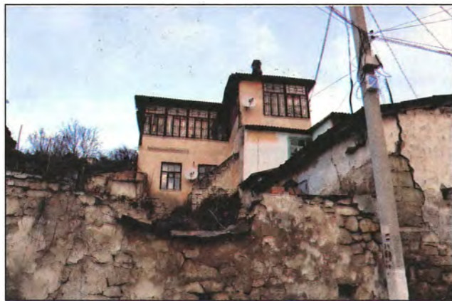
ул. И. Гаспринского, 6. Жилой дом во дворе Фото 2015 г.
