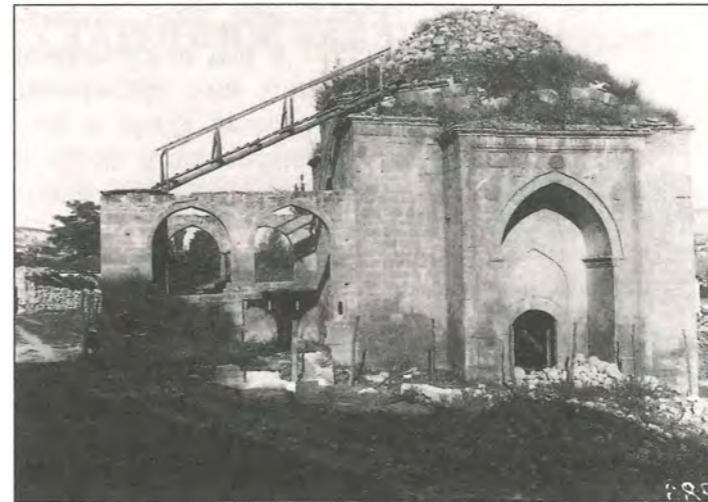
Эски-Дюрбе. Ремонтные работы. Портал и аркада (вид с восточной стороны). Фотография 1920-х гг. Из фондов БИКАМЗ № 690
