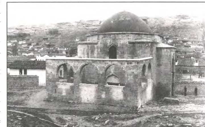
Эски-Дюрбе после ремонта. Вид с юга. 1928–1929 гг. Из фондов БИКАМЗ № 694
