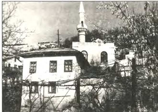
Тахталы-джами с разрушенной кровлей. Фото Попченко М. А., 1970-е гг.
