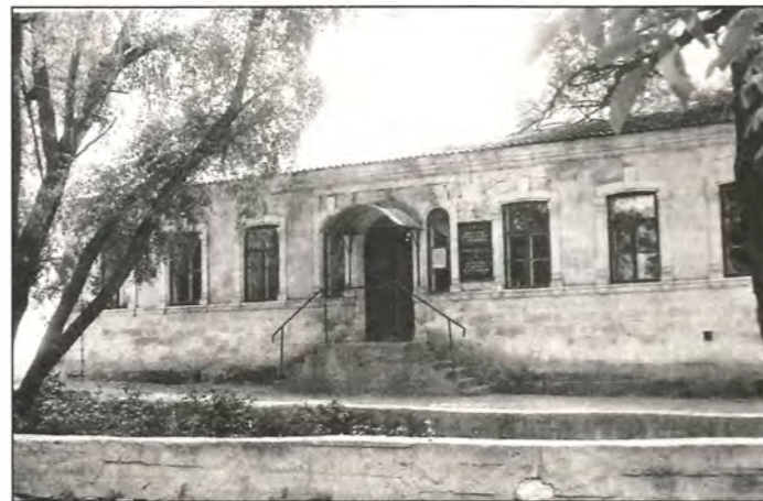
Дом Абдурахмана Челеби Крым-Хаваджи (Здание бывшей школы). ул. Речная, 125. Фото 1989 года
