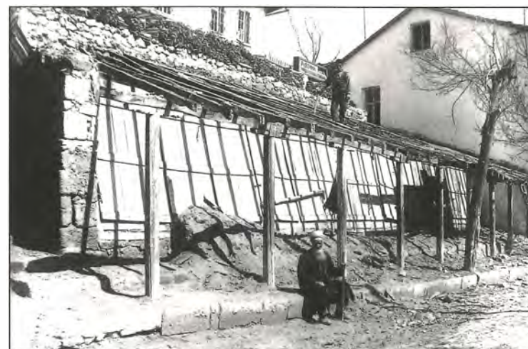
Древние ряды Кавафлар. Южный лицевой фасад после снятия черепицы и опалубки. Из фондов БИКАМЗ № 324
