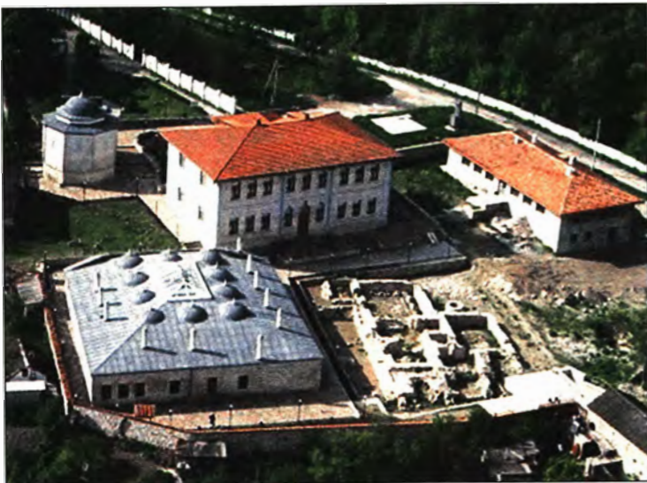
Остатки построек банного комплекса, расположенных рядом с медресе. Фото 2015 г.
