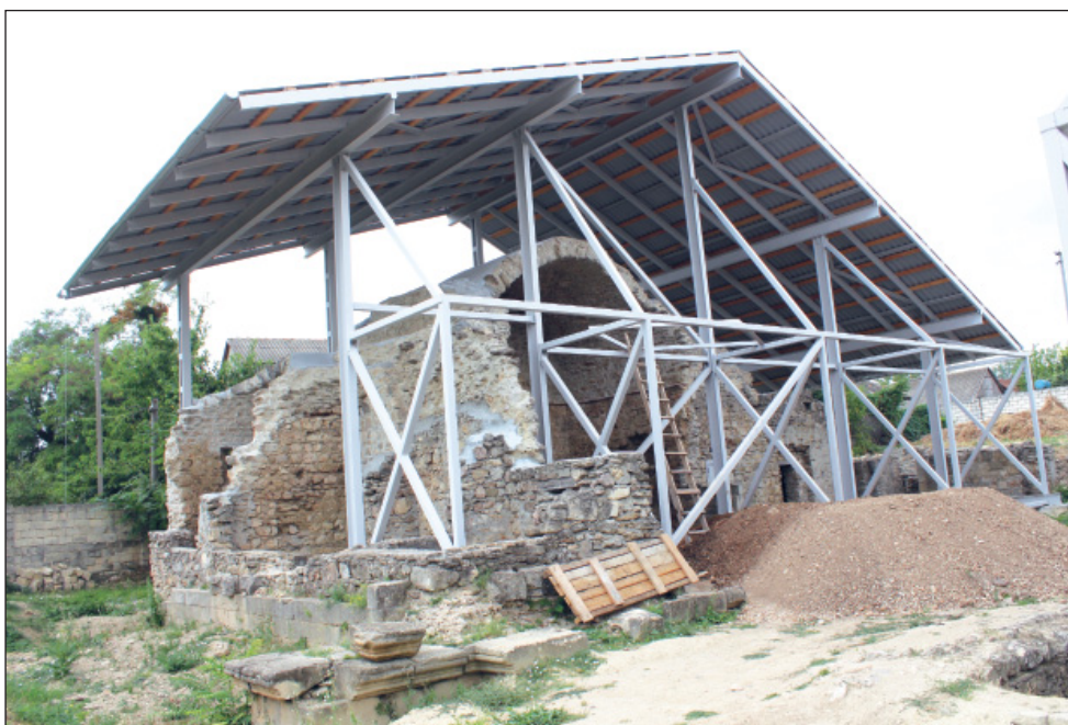
Навес над медресе. Южный айван. Современное состояние. Фото 2019 г.
