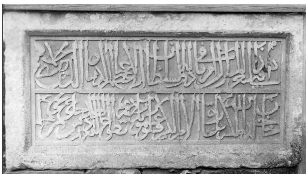
Рис. 10. Закладная плита, вмонтированная в стену мечети. Фото 1926 г. (Из книги «Мирас – Наследие» [Мирас – Наследие. Том 2, 2016, с. 488]).
