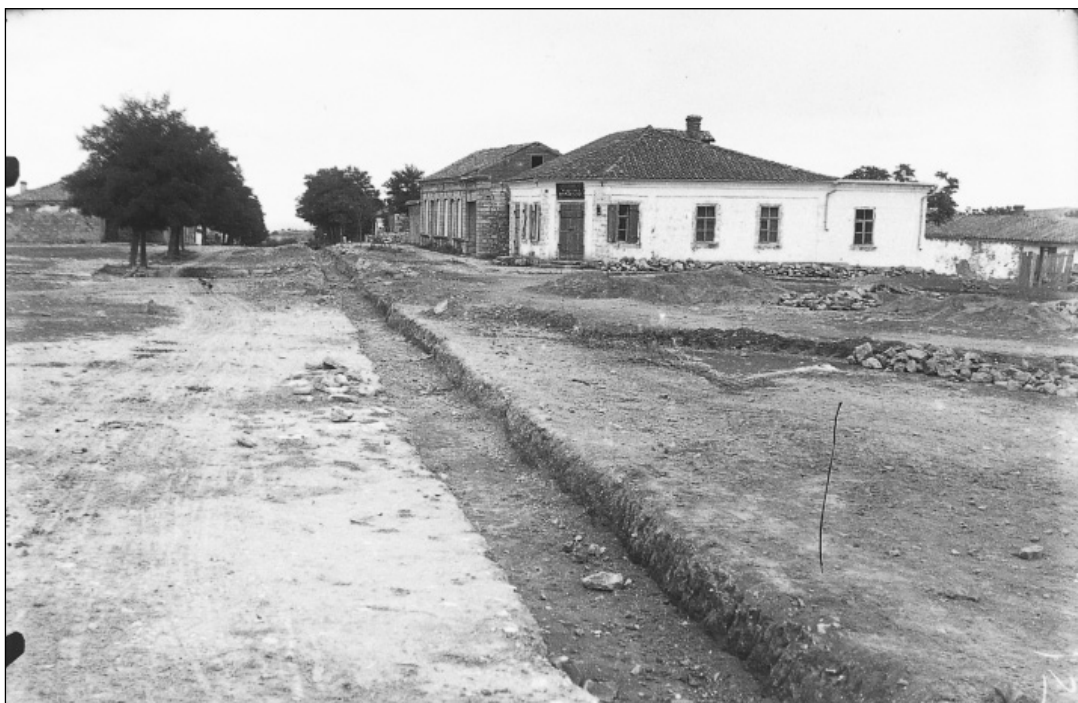
Земляные работы на территории города. Район ул. Отузской. Фото 20-х гг. XX в. (фото из фондов БИКАМЗ)
