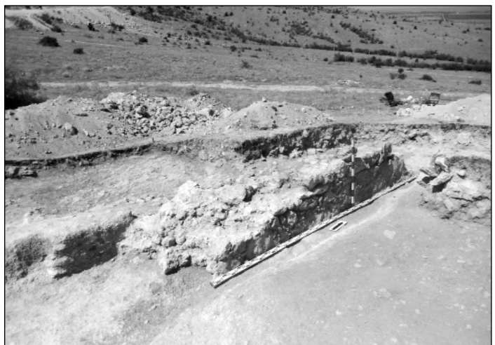
Раскопки крепостной стены и башни.
