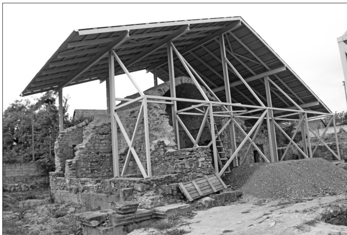
Медресе. Южный айван. Современное состояние. Фото 2019 г.
