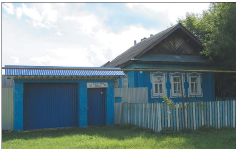
Жилой деревянный дом в с. Варзи-Омга, построен в 1977 г.
